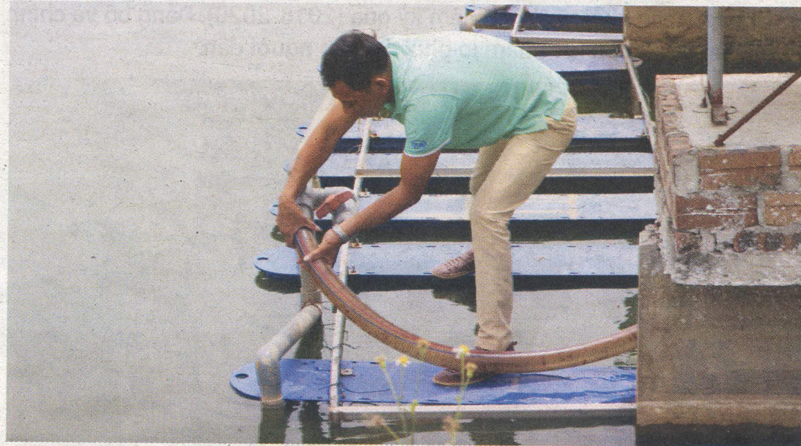
Anh Nguyễn Văn Thường kiểm tra đường ống dẫn khí từ bên ngoài vào bể. P.V
