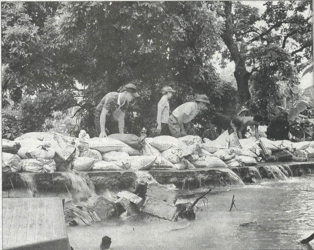
Đắp đê sông Đáy, đoạn qua xã Phù Vân, TP Phủ Lý.
